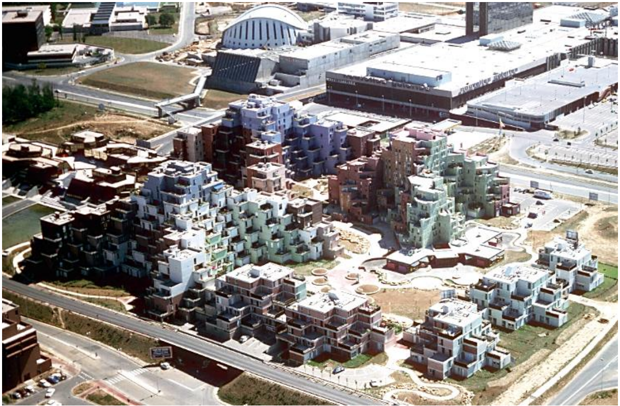
3 Le quartier des Pyramides lors de sa construction. Photo prise entre 1975 et 1976 par Dominique Planquette. Archives départementales de l'Essonne.
