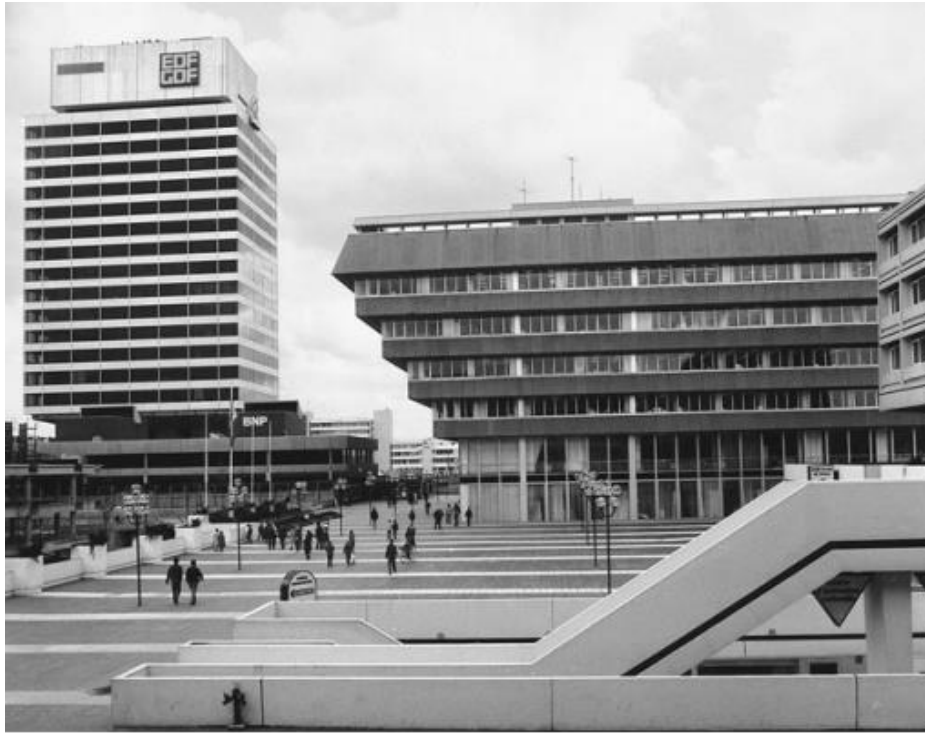
1 La place de la Préfecture de Cergy-Pontoise en 1977, avec notamment la préfecture bâtie par Henri Bernard et la tour EDF produite par Renzo Moro. Photo de J. Bruchet, IAU idF.
