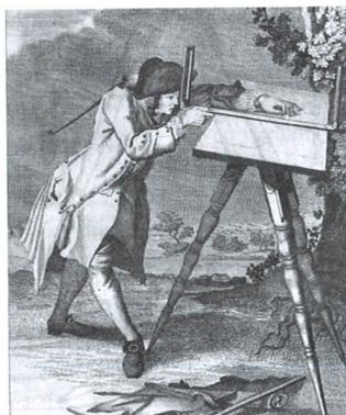
à pinnules ou lunette. Le plan était dessiné lors du levé, à la main, sur une feuille de papier posée sur la planchette. Il disparaît peu à peu avec l'apparition du tachéomètre et du théodolite.
