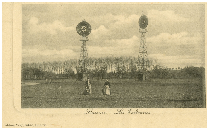
Les éoliennes de Limours, sans date. Arch. dép. Essonne - 57Fi98/65
