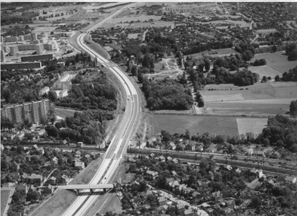
Construction de l'autoroute A6, 1960. Arch. dép. Essonne - 1236W.
