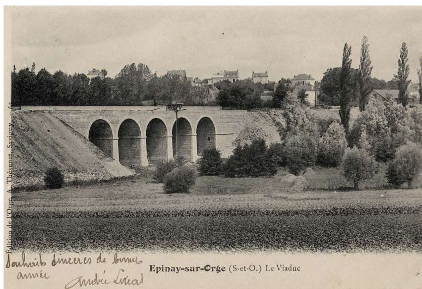
Doc. 14: Le viaduc d'Épinay-sur-Orge. Arch. dép. Essonne - 2Fi67/42
