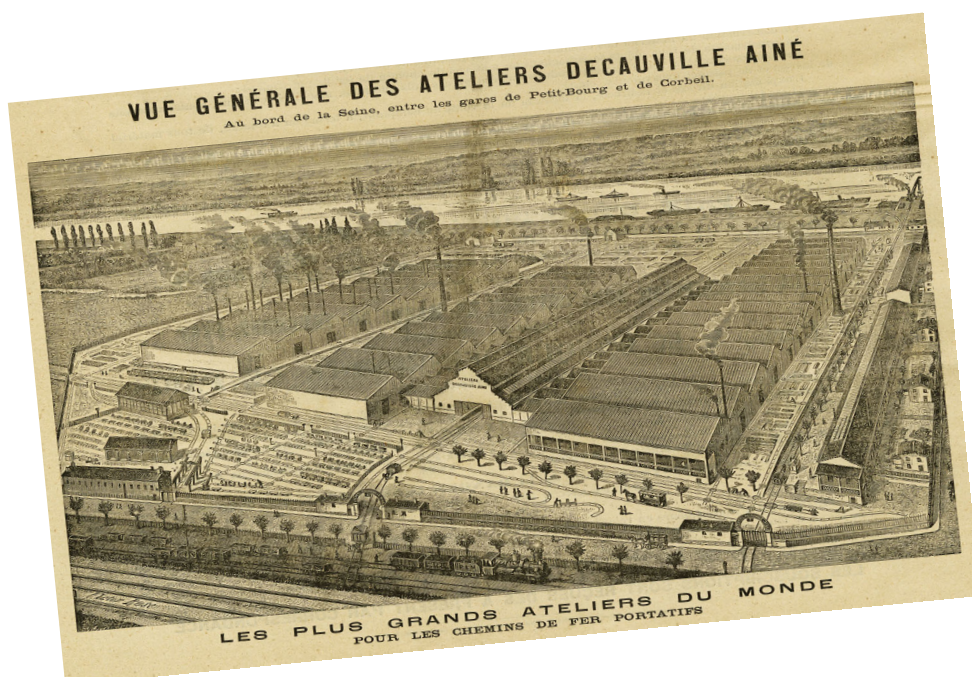
Doc. 21 : Vue générale des ateliers Decauville Ainé, 1882. Arch. dép. Essonne - 79J81/14
